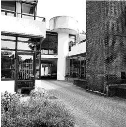
Deel van het hoofdgebouw van het sanatorium Zonnestraal met in het midden de watertoren en rechts de baksteen opgetrokken schoorsteen.
