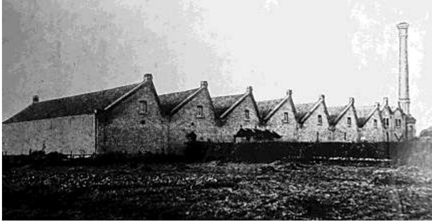
De fabriek die Gerard van Besouw in 1884-1885 liet bouwen aan de Kerkstraat in Goirle. Het bedrijf werkt met veertig weefstoelen.
