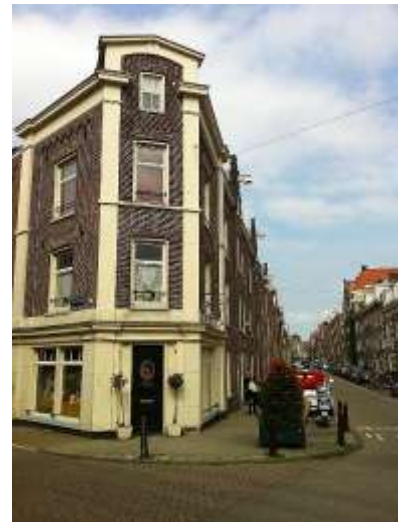
Hoek Lijnbaansgracht-Willemstraat. Het woningblok 132-150 is eind 19e eeuw het laatste nieuwbouwproject van de VAK.
