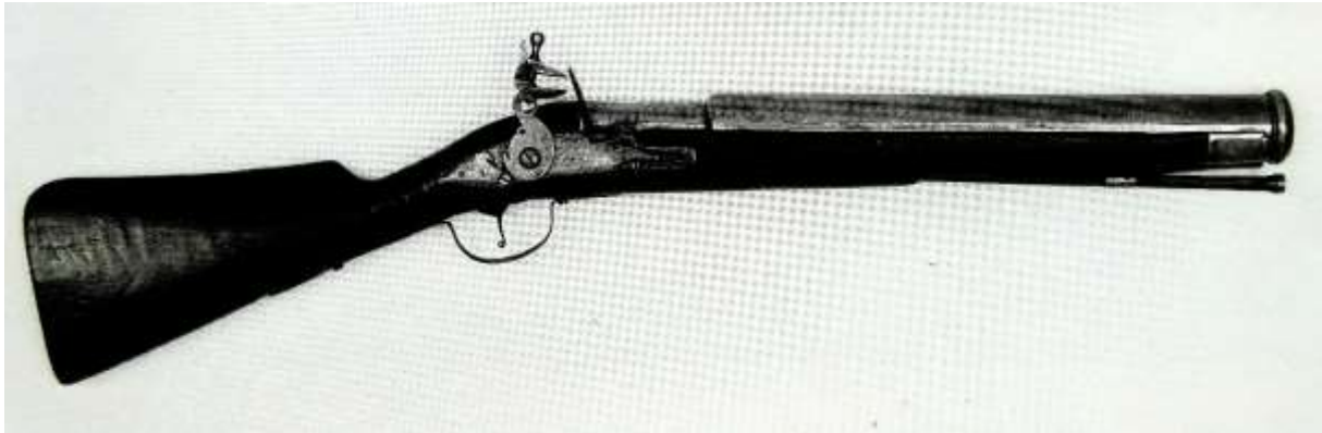
Een vuursteen donderbusgeweer voor gebruik op zee, gemaakt in Rotterdam in de jaren 1670-1690. De cilindervormige loop is van messing of brons. De smallere kulas draagt het keurmerk van Rotterdam met twee gekruiste ankers in een ovaal. Vermoedelijk is de bus gemaakt door de Rotterdamse geweermaker Abraham Stout, die in 1684 een partij van dergelijke geweren leverde aan de schepen 'Oranje' en 'Mercurius' van de Admiraliteit op de Maze.
