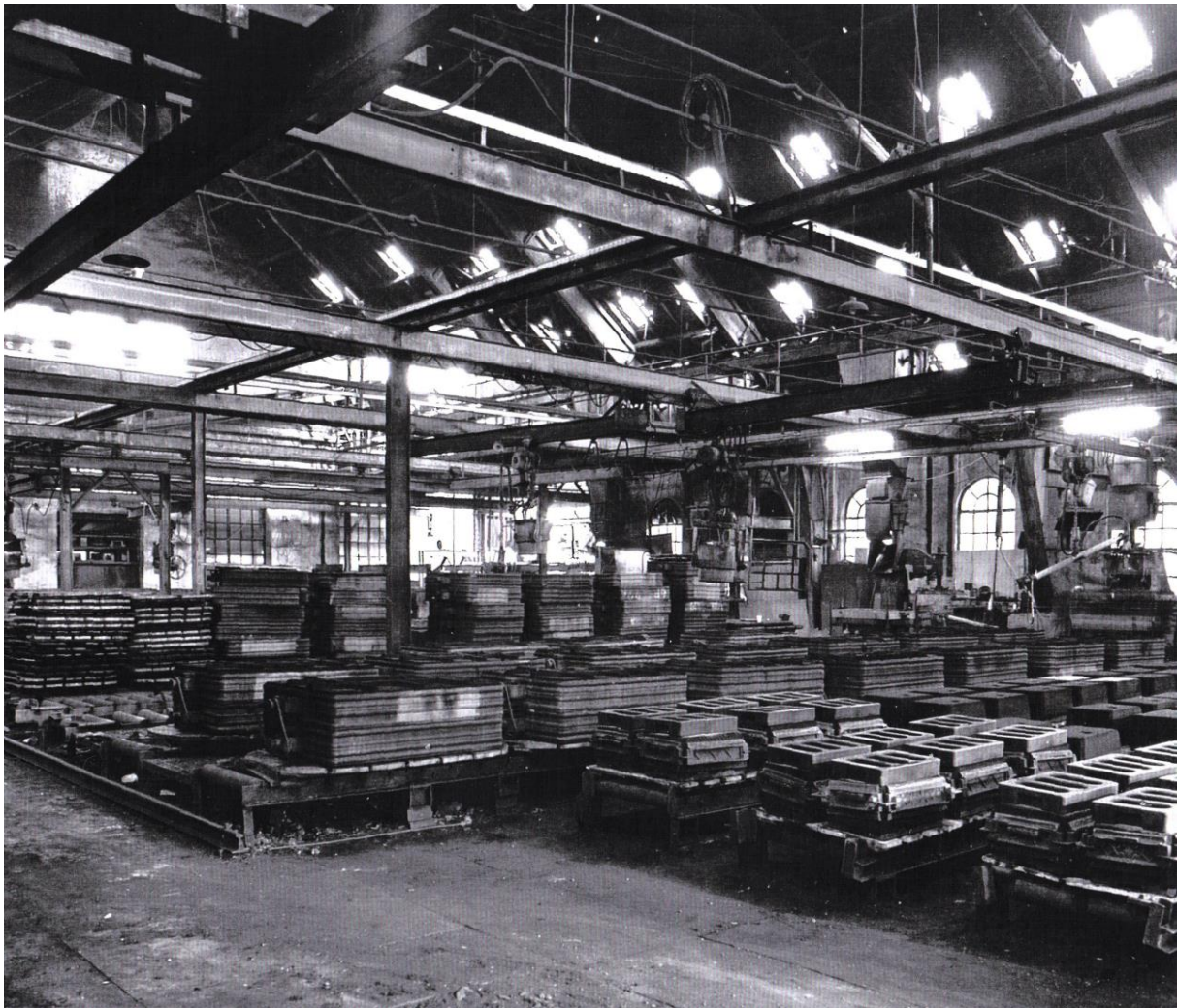
De giethal van de Keppelsche IJzergieterij in 1983. Niet lang daarna is het bedrijf gesloten. Enige jaren daarna zijn de historische bedrijfsgebouwen, ondanks dat ze tot rijksmonument waren verheven, onder de slopershamer gevallen.
