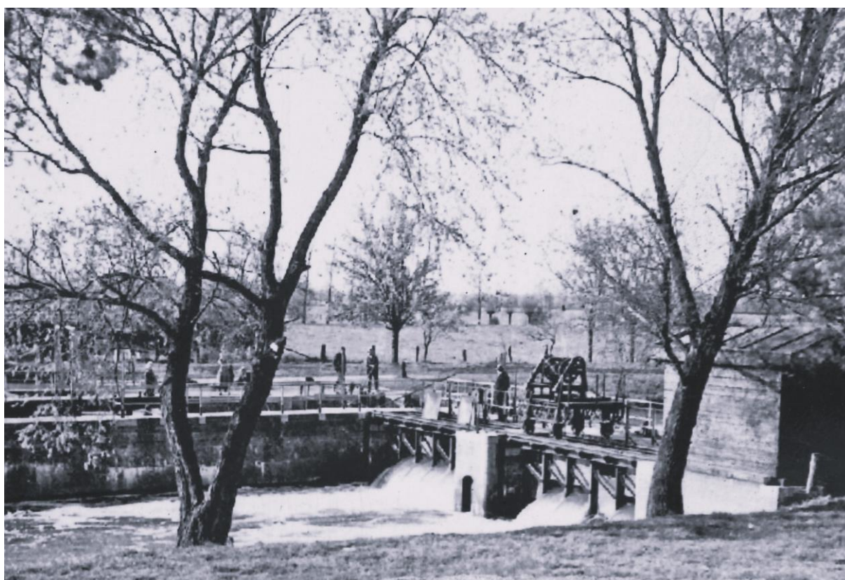
Een stemmig plaatje uit de eerste helft van de twintigste eeuw van stuw en sluis in de Oude IJssel te Laag-Keppel. De stuw laat goed het verval zien waarmee circa 250 jaar lang het waterrad en later de waterturbine van de Keppelsche IJzergieterij is aangedreven. Door het verleggen en kanaliseren van de Oude IJssel in 1953 verliezen stuw en sluis hun functie en de waterturbine van de Keppelsche komt stil te liggen. De stuw is verdwenen, maar de sluis met het oorspronkelijke ijzeren bruggetje bestaan nog en zijn in 2005 gerestaureerd.
