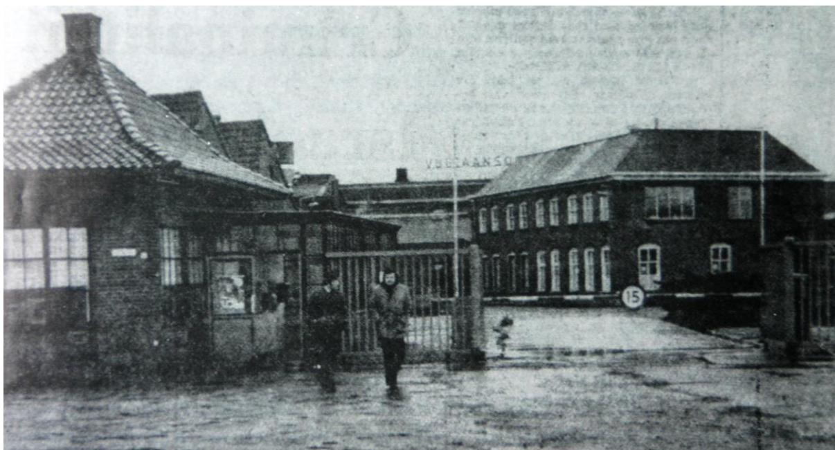
De stilte aan de poort van Vulcaansoord in Terborg/Gaanderen na sluitingstijd. Het faillissement van het bedrijf is in 1977 uitgesproken en twee jaar later zijn de bedrijfsgebouwen, waar eens zo'n 1000 mensen hun brood verdienden, gesloopt.
