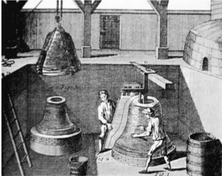
Schematische voorstelling van het maken van een klok, uit Diderot & d' Alembert, L' Encyclopedie on dictionaire raisonne des sciences, des arts et des metiers. (Parijs 1751-1772). In de gietkuil zijn twee klokkengieters, met behulp van een sjabloon de wand van een valse klok in model aan het brengen.
