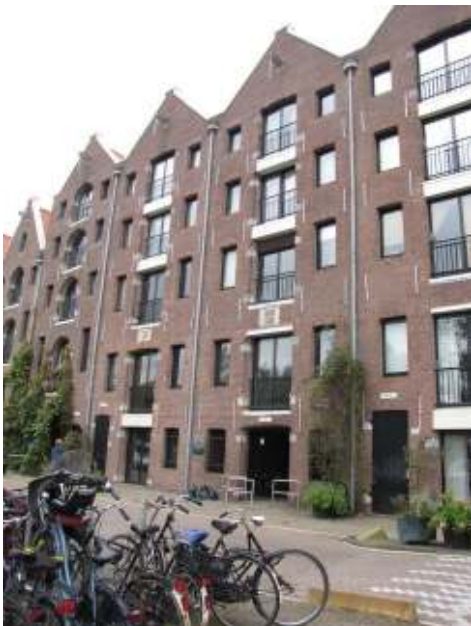
Dit deel van het Entrepotdok in Amsterdam is tot stand gekomen in de jaren 1837-1840. Het bouwwerk bevat meer dan 200 gietijzeren kolommen en is het eerste voorbeeld van toepassing van gietijzer in de bouw in Nederland. (foto: Baronas)
