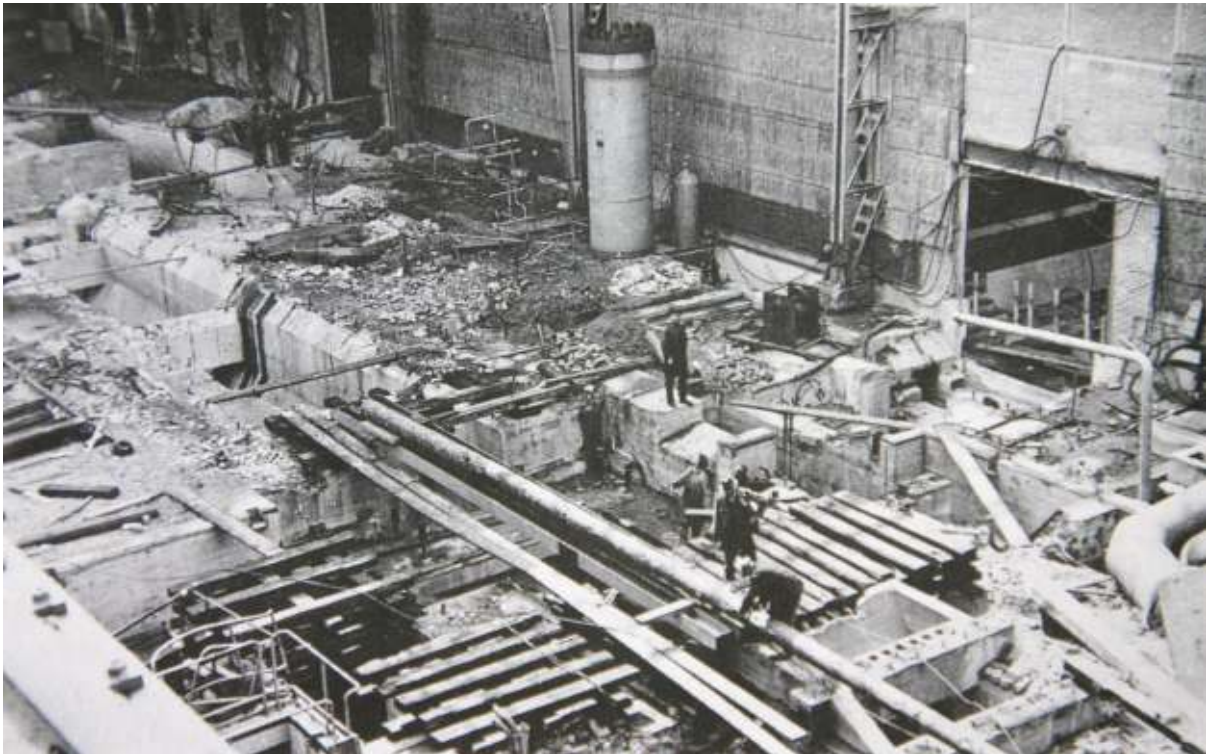
De kale fundamenteën van Walserij-West. De walserij voor dikke plaat is in 1943 nog maar net voltooid als de bezetter het walswerk uit elkaar haalt en afvoert naar de Hermann Goering Werke in Watenstedt (D.). Eerst in 1947 kan de walserij weer in bedrijf worden genomen.
