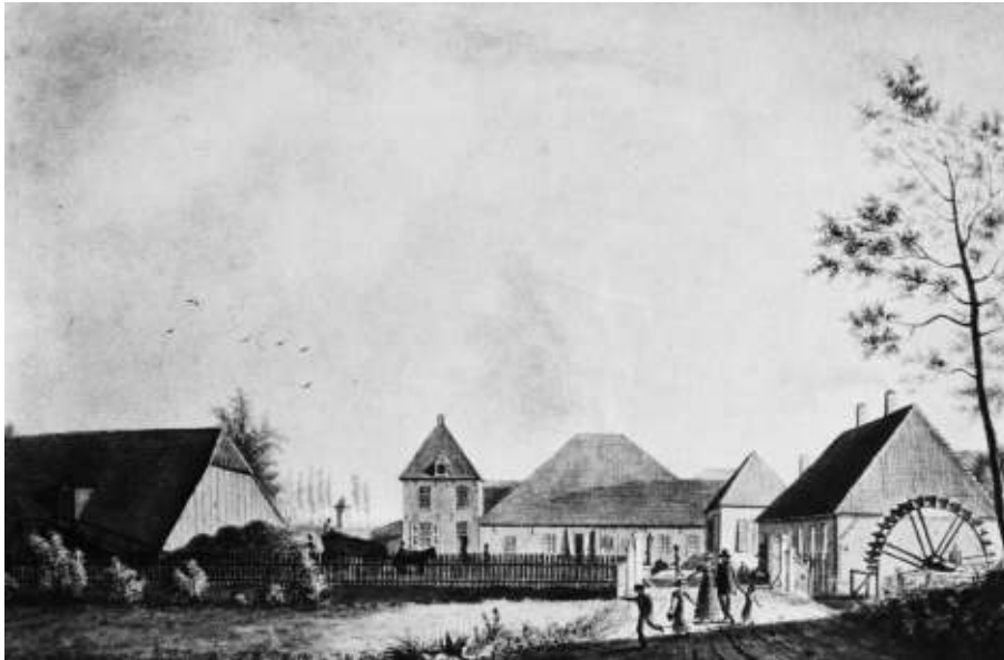
Van der Horst en Aberson, de latere Keppelsche Ijzergieterij, te Laag-Keppel rond 1840. De tekening van Alexander Ver Huell toont het bedrijf van de voorzijde. Het grote waterrad rechts op de tekening heeft een doorsnede van circa zeven meter.
