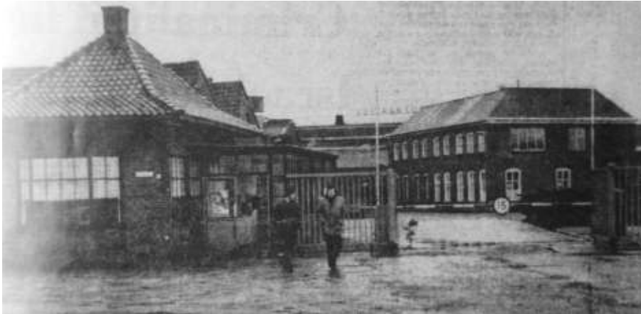
De stilte aan de poort van Vulcaansoord in Terborg / Gaanderen na sluitingstijd. Het faillissement van het bedrijf is in 1977 uitgesproken en twee jaar later zijn de bedrijfsgebouwen, waar eens zo'n 1000 mensen hun brood verdienden, gesloopt.
