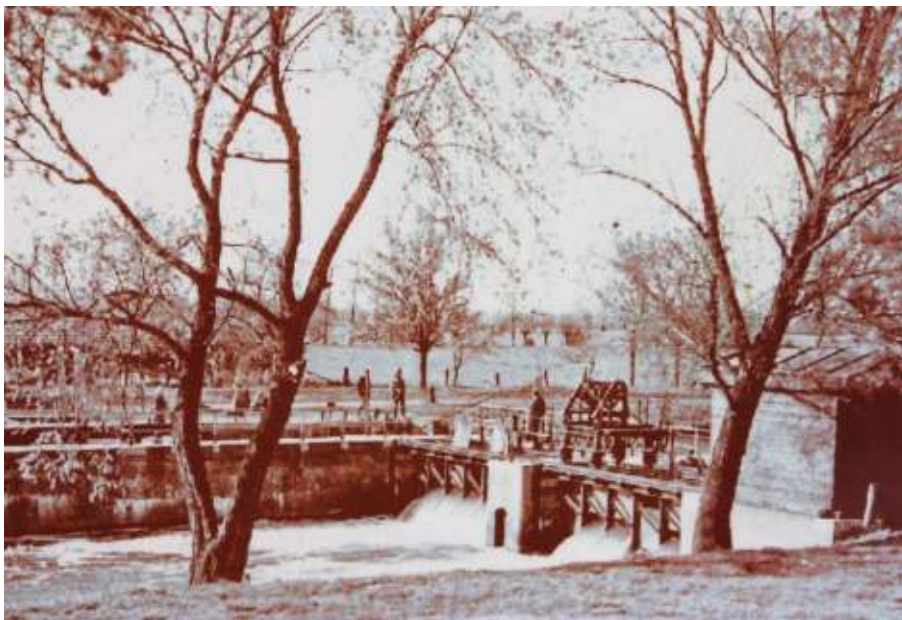
Eens stemmig plaatje uit de eerste helft van de twintigste eeuw van stuw en sluis in de Oude IJssel te Laag-Keppel. De stuw laat goed het verval zien waarmee circa 250 jaar lang het waterrad en later de waterturbine van de Keppelsche IJzergieterij is aangedreven. Door het verleggen en kanaliseren van de Oude IJssel in 1953 verliezen stuw en sluis hun functie en de waterturbine van de Keppelsche komt stil te liggen. De stuw is verdwenen, maar de sluis met het oorspronkelijke ijzeren bruggetje bestaan nog en zijn in 2005 geres-taureerd.
