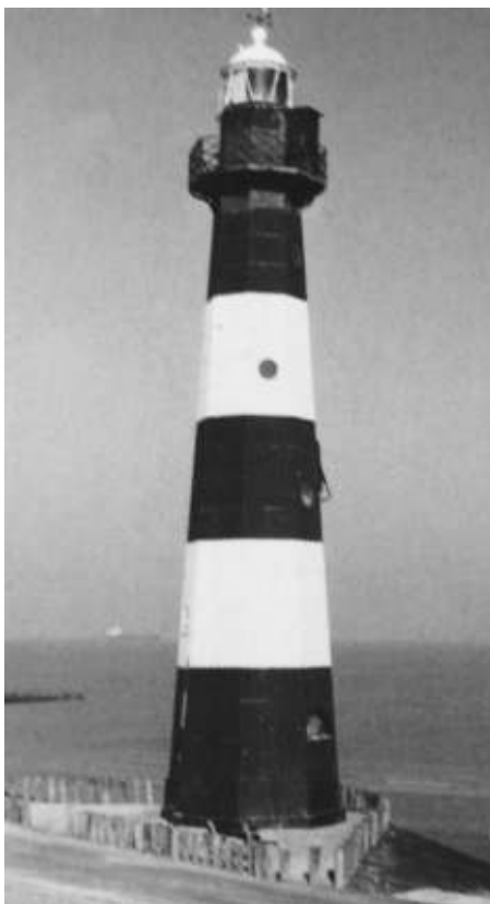
De vuurtoren te Breskens in Zeeland is gebouwd door L.I. Enthoven & Co. in 1867. Het is nu de oudste gietijzeren vuurtoren van Nederland, nadat die te Renesse en Ouddorp zijn afgebroken. De lighthouse is 28 meter en laat afwisselend om de 10 seconde een wit, rood en groen licht zien. Het witte licht is tot een afstand van 14 zeemijl waar te nemen.
