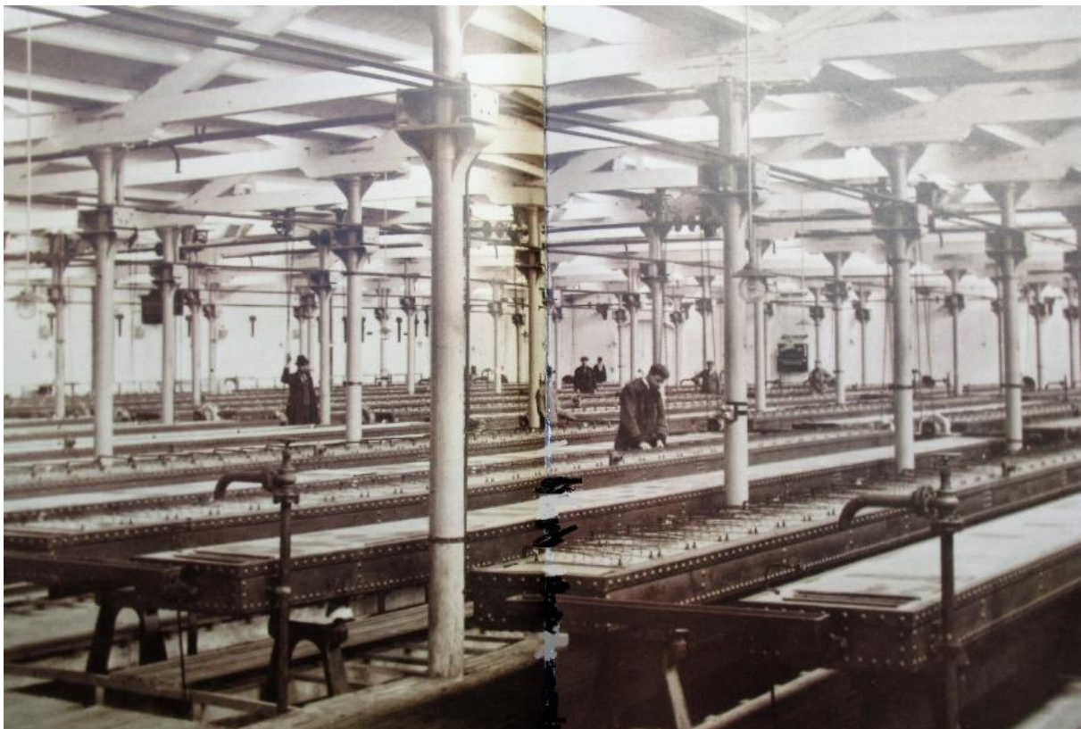
De elektrolysehal van het elektrolysebedrijf in Jemeppe-sur-Sambre in België, dat door Solvay in 1898 in gebruik is genomen.
