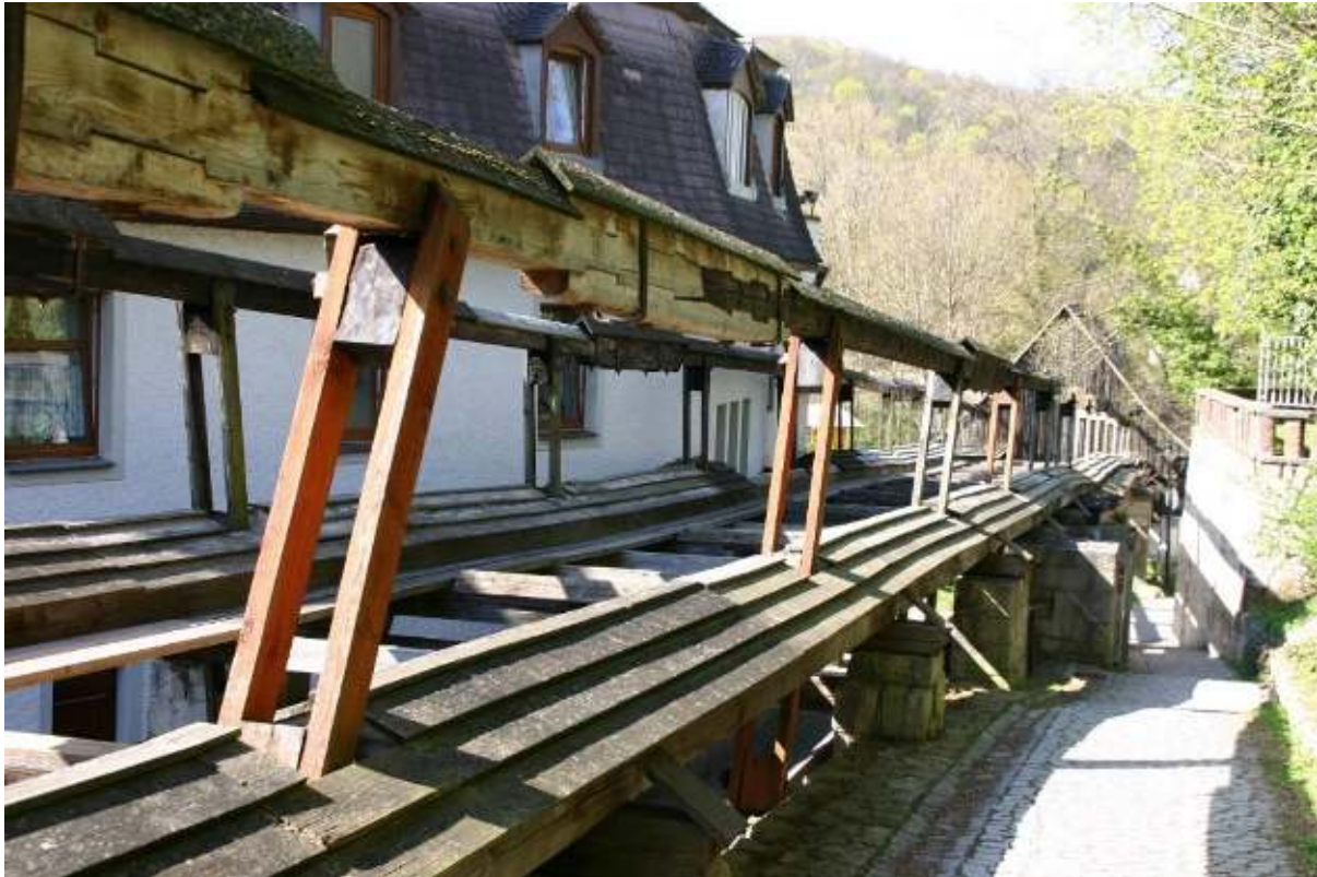
De lattenoverbrenging van een Polhem-waterwiel in Bad Kosen in Duitsland (Thüringen). In 1730 stoten mijnwerkers op een zoutbron. Met behulp van een waterwiel en een lattenoverbrenging van enige honderden meters wordt een plunjerpomp aangedreven die de pekkel oppompt. In het naastgelegen gradeerwerk, waar het zoute water over sleedoorntakken wordt geleid, wordt het zoutgehalte verhoogd. Het zout wordt daarna gewonnen in de ziederij. Het Polhem-waterwiel en lattenwerk werkt na meer dan 250 jaar nog steeds. (foto: Baronas)
