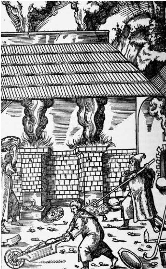
Een van de vele prachtige houtsneden in De re metallica Libri XII van de hand van Georg Agricola. Illustratie van een smeltoven met A. De smeltoven en B. De voorhaard. De voorstelling toont een 'Stückofen' zo genoemd aangezien deze oven grotere wolven (stukken) kon produceren dan de renhaarden van de woudsmeden.
