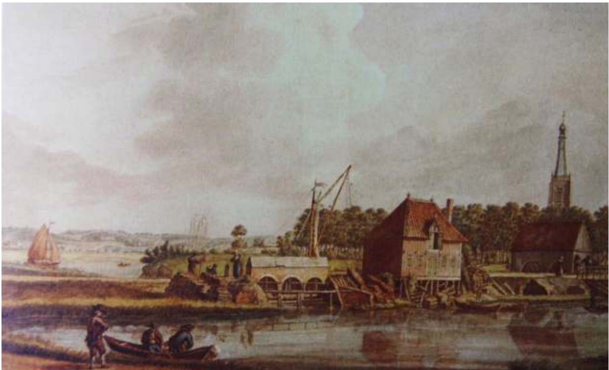
Doesburg bij de uitmonding van de Oude IJssel in 1743. Op de voorgrond de Molenkolk en op de achtergrond de Gelderse IJssel. Goed is te zien dat de sluis een keersluis is, waar geen schepen door kunnen. De goederen afkomstig van de ijzermolens moesten hier worden overgeslagen. Naar een gekleurde tekening van Jan de Beijer.
