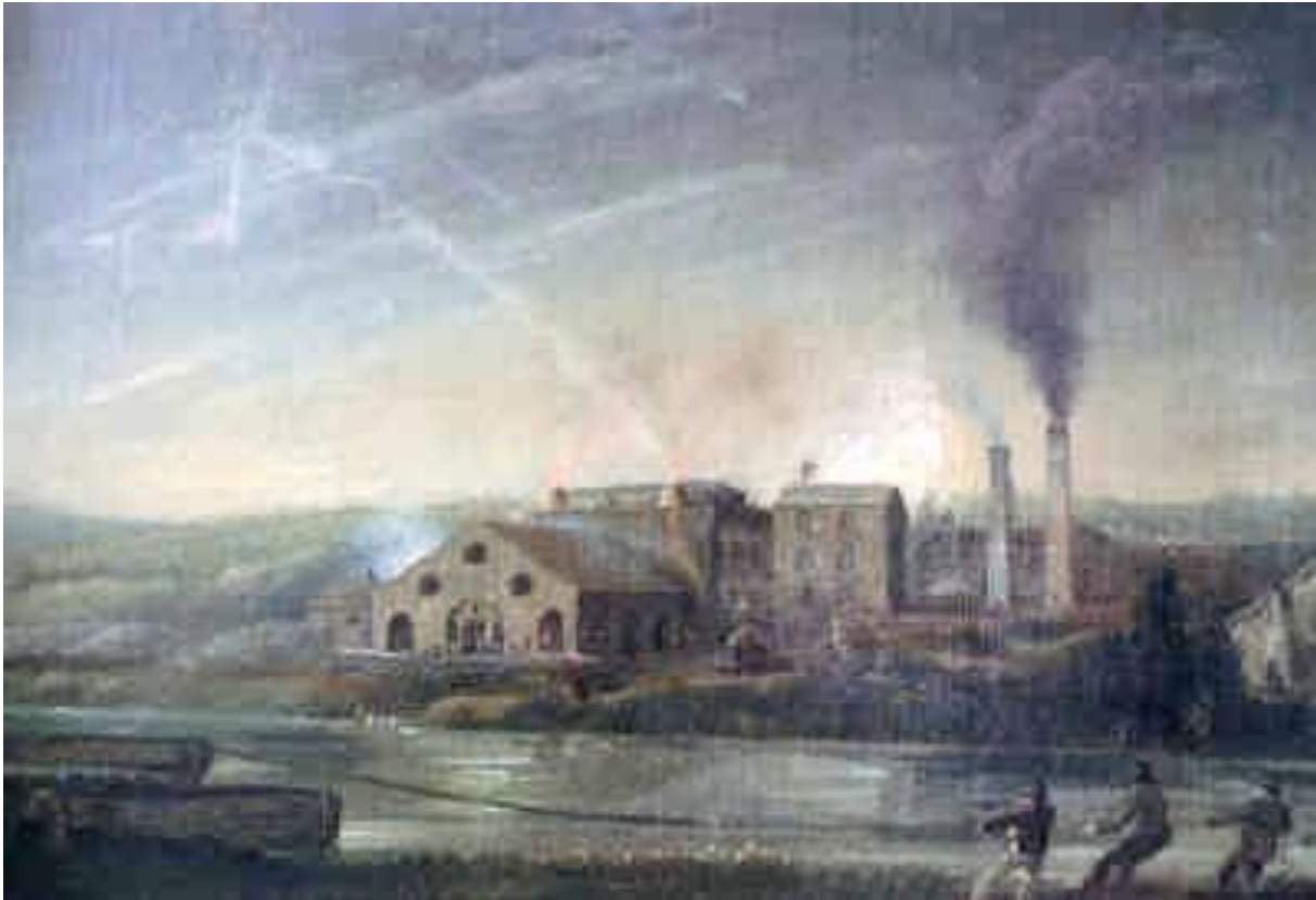
Ynysfach Ironworks te Merthyr Tydfil in Wales. Al in 1769 is er op deze plaats een ijzermolen actief. In 1801 worden er twee nieuwe hoogovens gebouwd met een hoogte van 53 voet (ca. 16 m), wat in die tijd zeer aan de maat is en met een door een stoommachine aangedreven blaaswerk. Het bedrijf is in 1874 stilgelegd. Naar een waterverfschilderij van Penry Williams ca. 1825.
