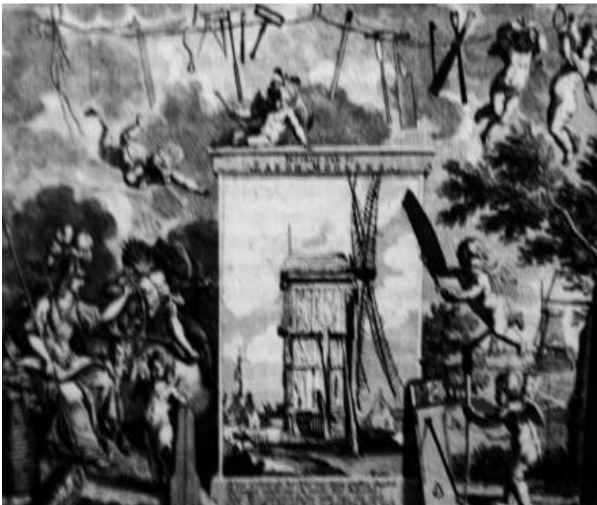
Zinneprent uit de zeventiende eeuw van A. van der Laan op de uitvinding van de houtzaagmolen door Cornelis Cornelisz. van Uitgeest. Voor de toepassing van het principe van de krukas in een zaagmolen, krijgt Van Uitgeest in 1597 een octrooi van de Staten van Holland. De productiviteit van de houtzagerij wordt met de krukas sterk verbeterd.
