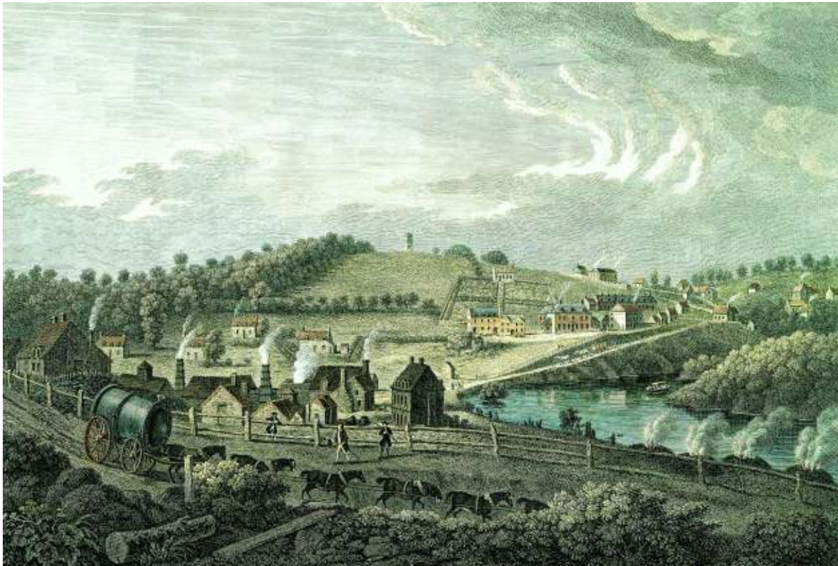
Gezicht op de 'Upper Works' te Coalbrookdale in 1758. Naar een handgekleurde gravure van François Vivares. Een ijzeren stoommachinecilinder wordt met paardentractie vervoerd. In het midden de fabrieken van Darby. Rechts zien we Dale House waar de Darby's woonden. Rechts op de voorgrond wordt cokes gemaakt van smeulende hopen steenkool.
