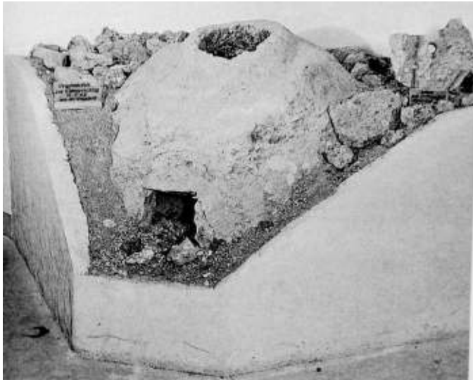
Een renhaard uit de La-Tène-tijd. Gevonden in Engsbach in de omgeving van Siegen. De oven staat nu in het Siegerland Museum te Siegen. (foto: Dina)
